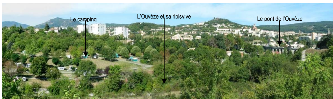
LA VALLEE DE L'OUVEZE – VUE DEPUIS LA ROUTE RD 2
