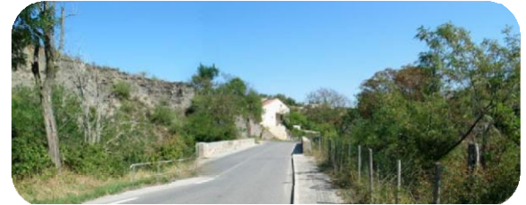
ENTREE OUEST DEPUIS ST PRIEST: UNE TRAVERSEE DISCRETE DE L'OUEZE
