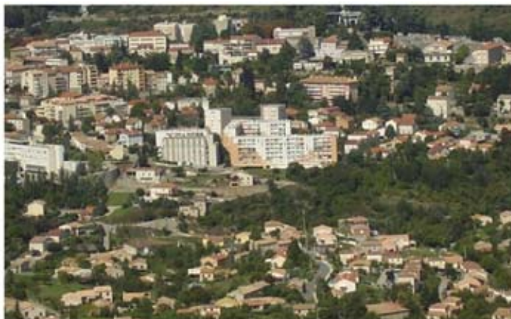
IMMEUBLES DES QUARTIERS LANCELOT, GRATENAS, LE VANEL, LA CHAUMETTE ET HABITAT INDIVIDUEL EN RIVE DROITE DE L'OUVÈZE
