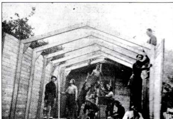
Construction d'une baraque
