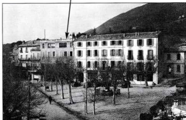
Le Bazar après les travaux de rénovation
